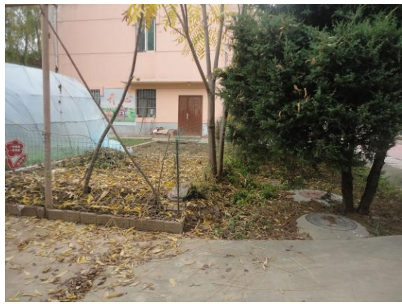
新建河站化粪池
