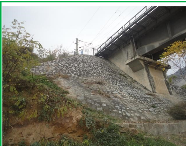
桥梁锥体防护
