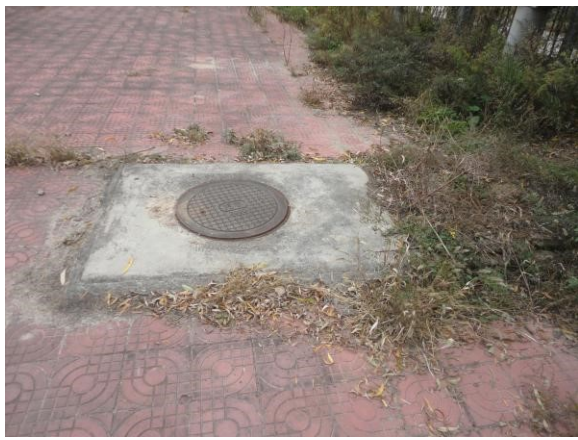
元龙站化粪池
