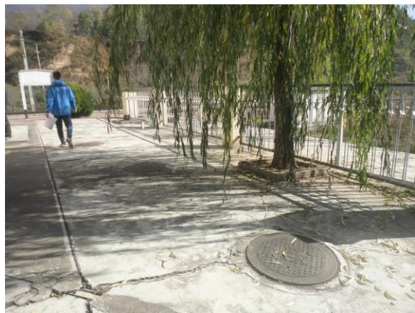
马家湾站化粪池
