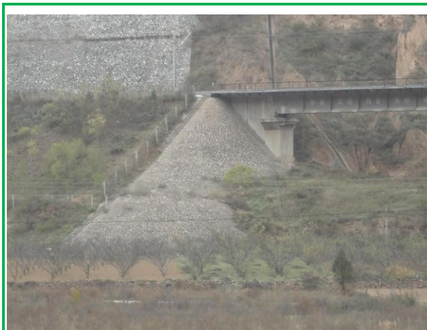
桥梁锥体防护
