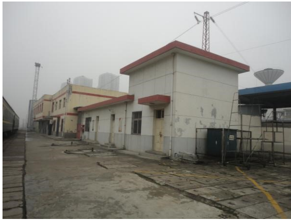
宝鸡客整所沉淀隔油池及提升泵井
